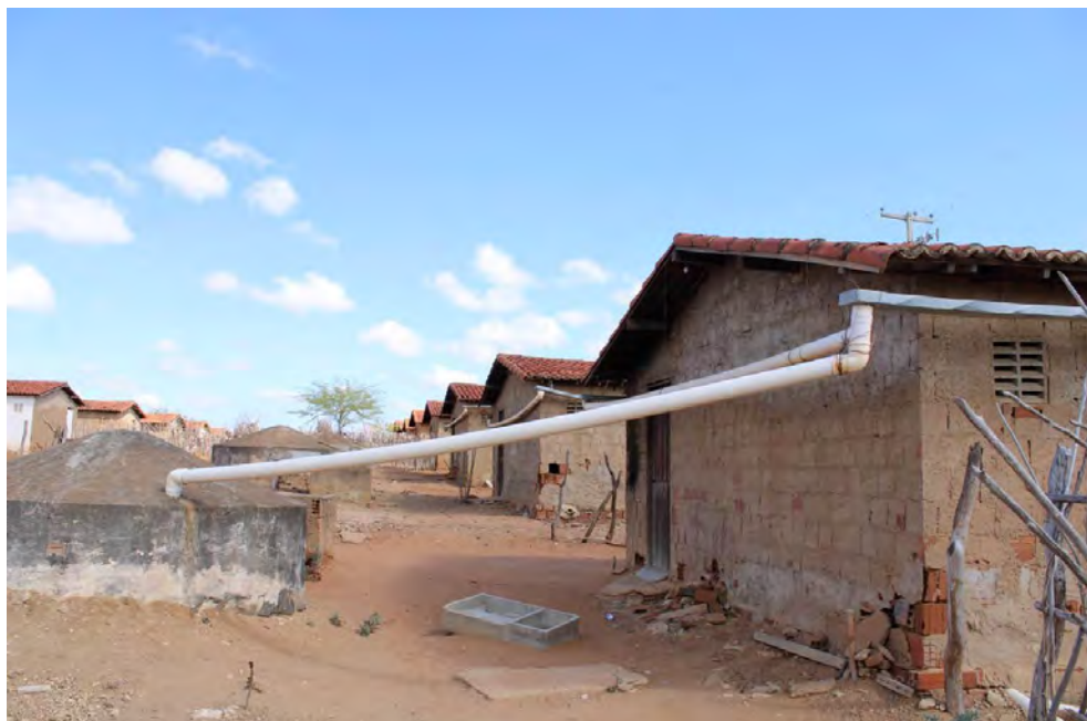
Figura 7: Vista dos fundos da E. M. José Ferreira de Araújo. Em evidência, a paisagem da vizinhança, com as demais casas da comunidade casinhas, Vila 2
