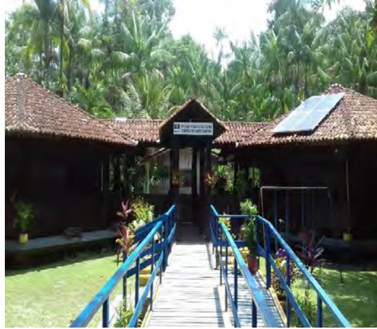
Figura 2: Fachada da Unidade Pedagógica do Combu
