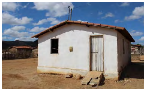
Escola 4 - Escola Municipal José Ferreira de Araújo.
