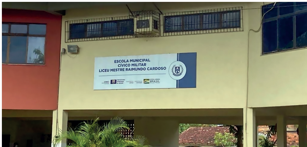
Figura 7 - Fachada da escola após a implantação do PECIM.
